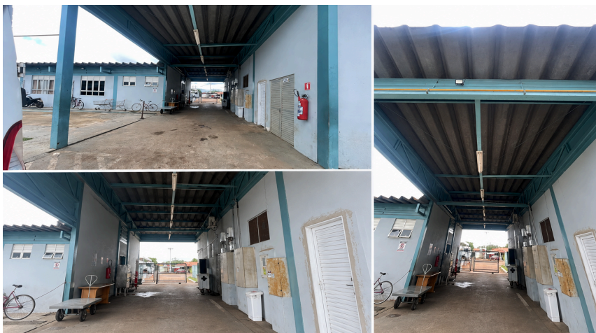
Figura 3: Registros fotográficos de diferentes ângulos da Zona F no Hospital Regional de Paraíso do Tocantins.
