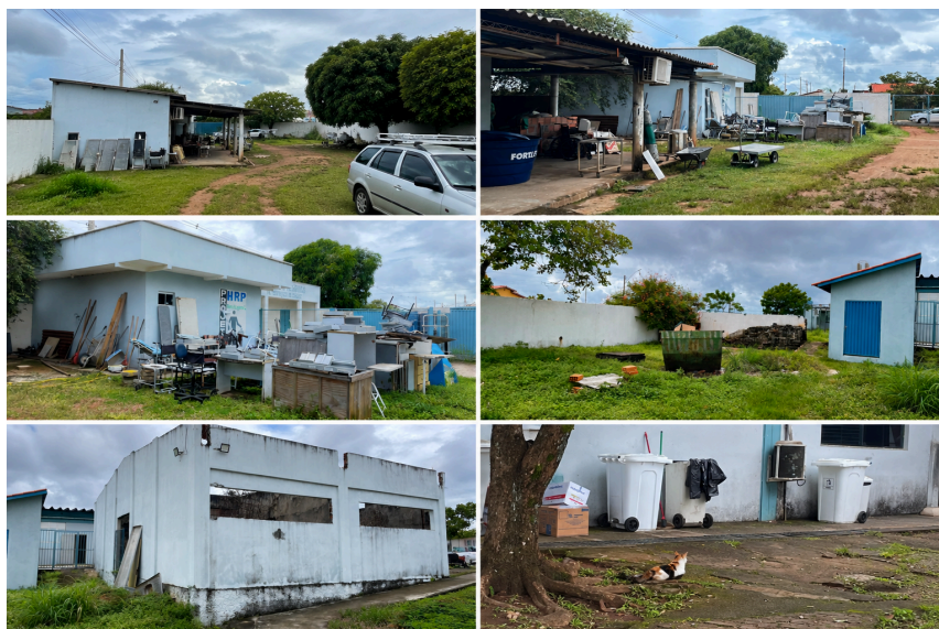
Figura 2: Registros fotográficos de diferentes ângulos da Zona B no Hospital Regional de Paraíso do Tocantins
