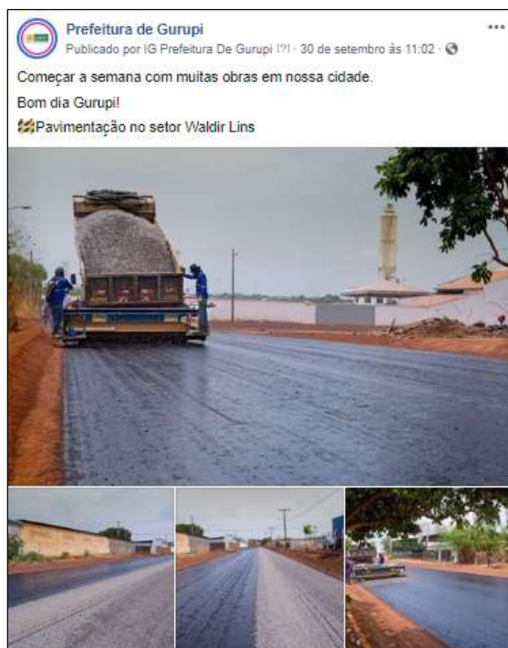
Figura 8 – Postagem obras de pavimentação em 30/09/2019
